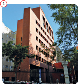
Edificio Bankinter en Madrid (España).
